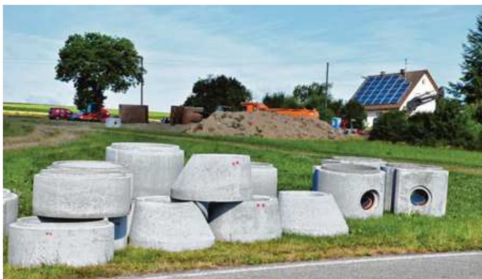
Im Süden von Scherstetten entsteht ein Gewerbegebiet. Seit ein paar Tagen laufen dort die Erschließungsarbeiten.
